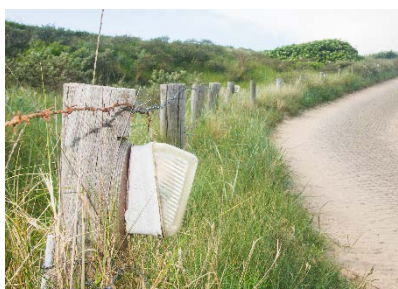
1. Oude armaturen die veel lichtvervuiling geven. Het licht straalt omhoog en naar voren.
