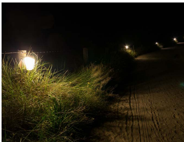
Verlichting duinpad vóór uitvoering pilot: de armaturen stralen naar boven en naar voren, het licht is van grote afstand zichtbaar
