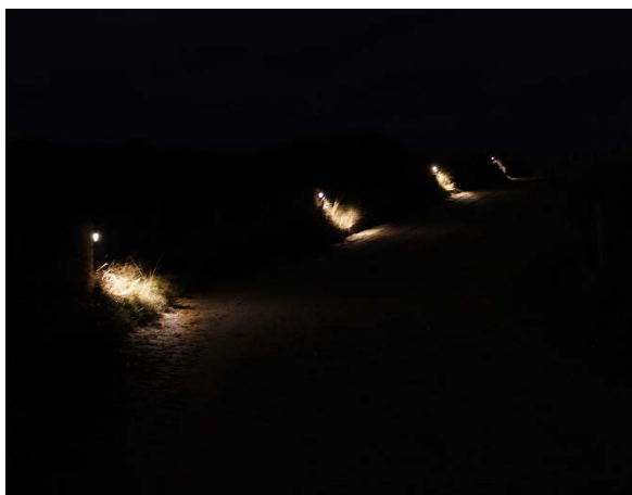
Verlichting duinpad ná uitvoering pilot: de nieuwe armaturen stralen het licht recht naar beneden, hierdoor is er minder lichtvervuiling
