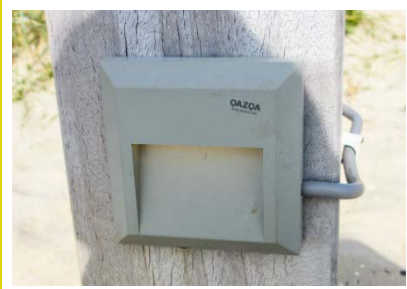
3. Armatuur zoals gebruikt in de pilot. Dit type richt het licht nog beter en geeft nog minder hinder.
